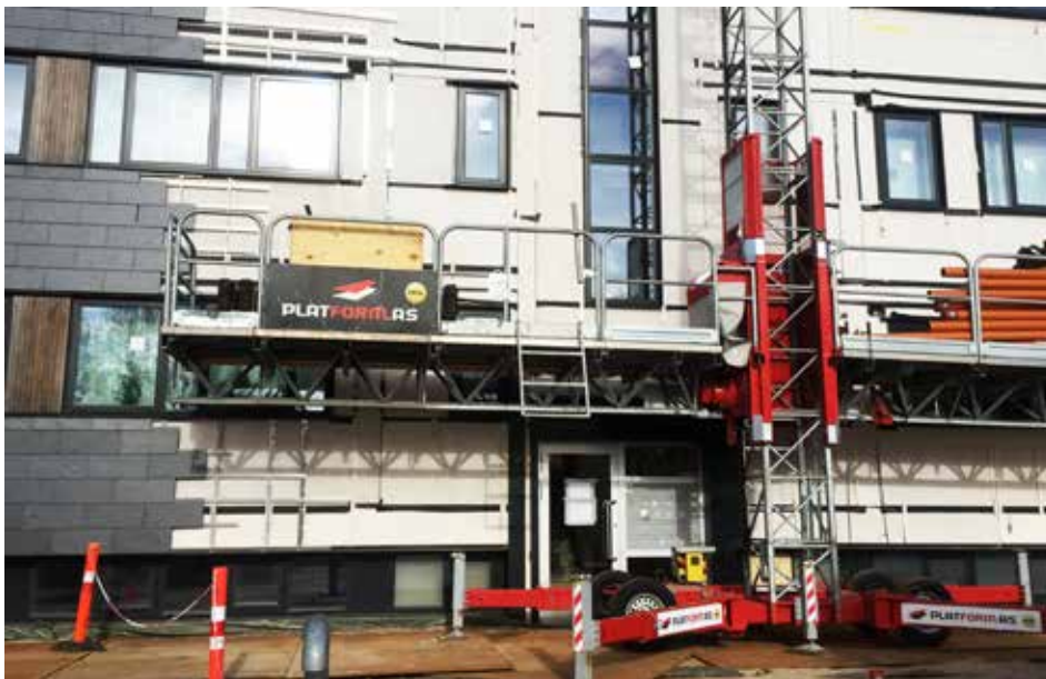
Blok 30, 2017 Udskiftning af MGO-plader.
