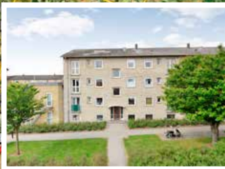
Afd. 307 Henrik Hertz Vej og Afd. 308. Vibyvej Efter en gennemgang af afdelingerne besluttede byggeudvalget at ansøge Landsbyggefonden om midler til en samlet helhedsplan for begge afdelinger.
