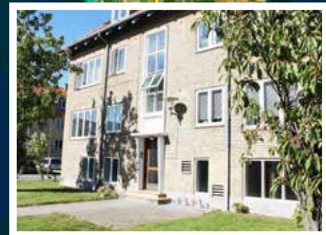
Afd. 305 Anker Jensens Vej Vinduerne i afdelingen trængte til en udskiftning, og alle vinduer både udvendigt og indvendigt er derfor blevet skiftet.
