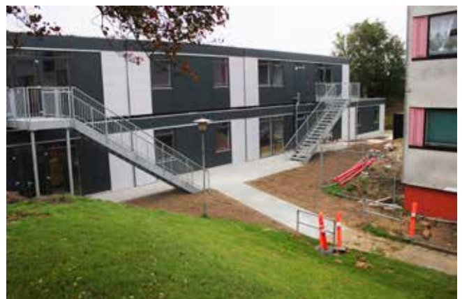
Pavillonby med aflastningsboliger i Åbyhøjgård.
