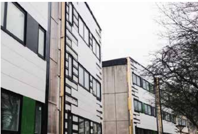
Eksisterende og ny facade i Åbyhøjgård, afd. 310.
