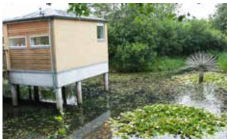
Afdeling 315 får støtte til flydebro i søen ved fælleshuset
